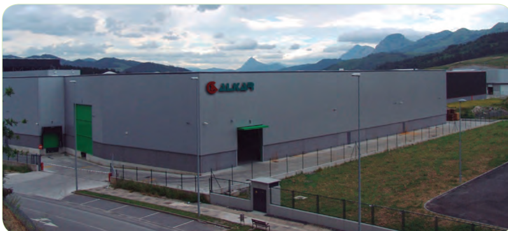
Vista de almacén / Warehouse view
